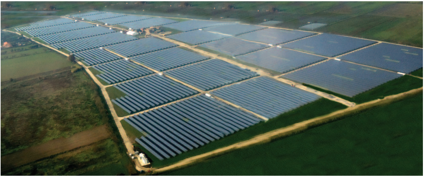
Parque Fotovoltaico en Campania, Italia
