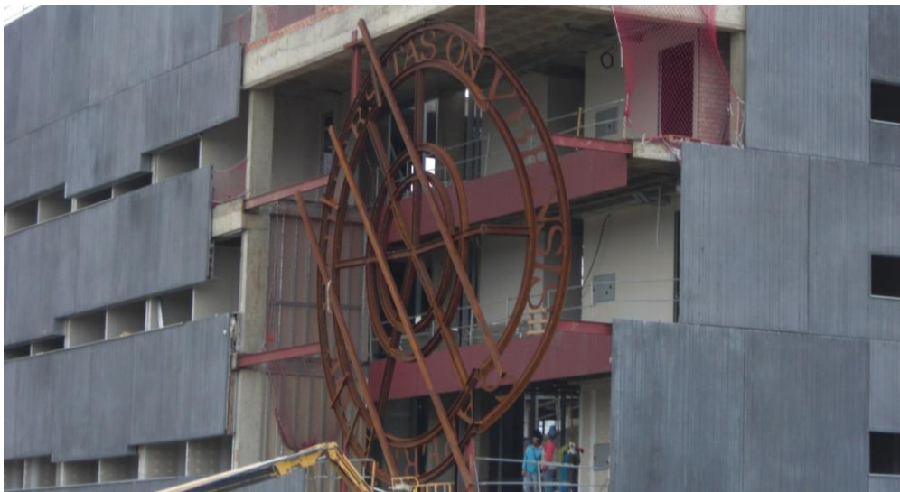
Edificio en construcción. Campus de El Carmen.
