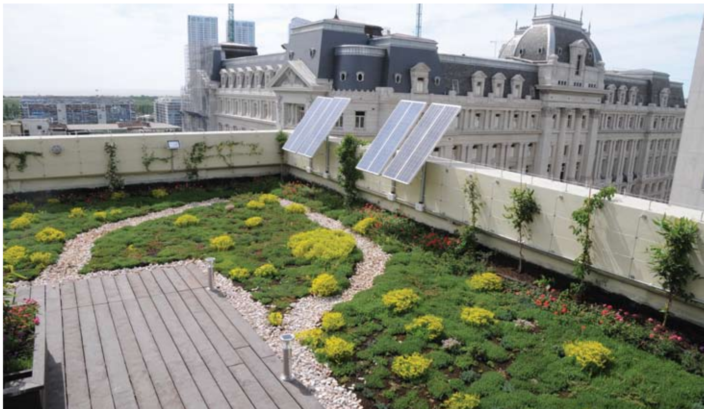
← Green roof con 8 paneles fotovoltaicos y un molino de eje vertical de 2,5KW de potencia.
